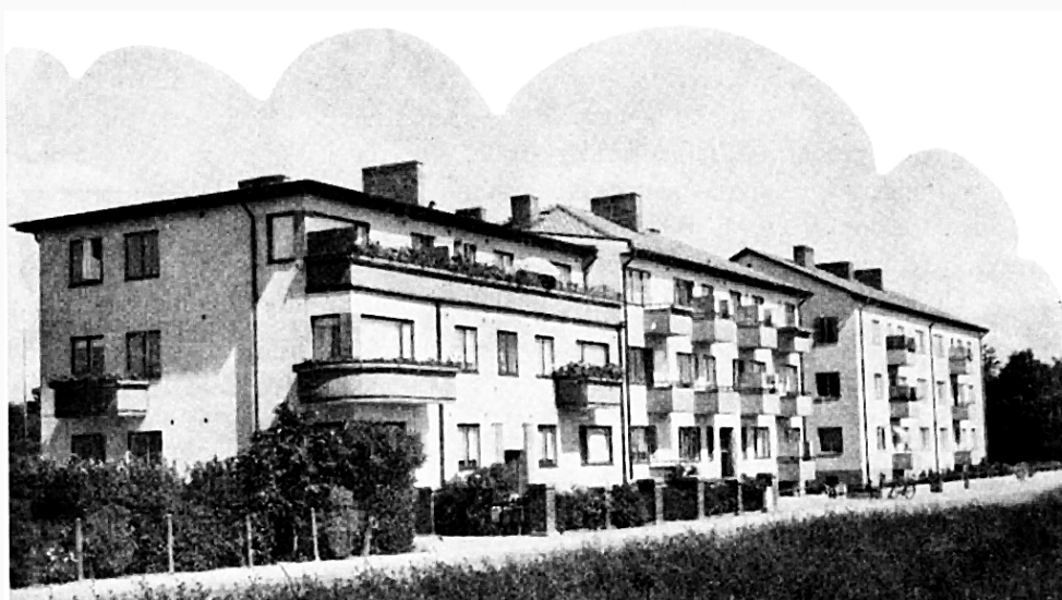
Arkitekturen är av modernaste slag i nybyggena
